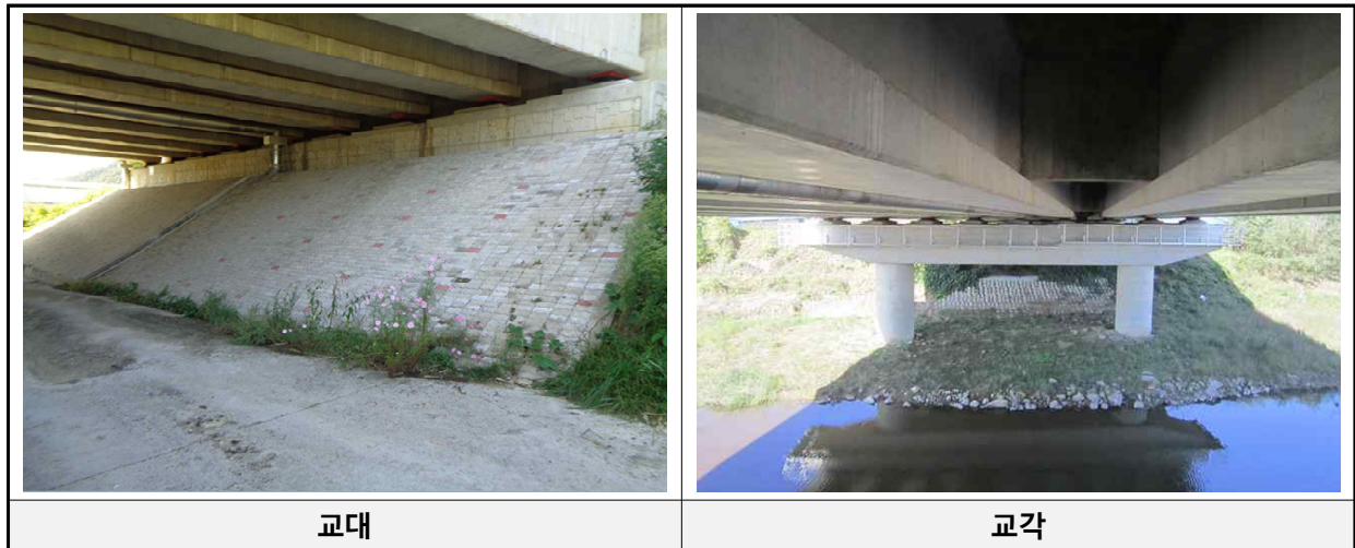
[교대 및 교각 전경]
