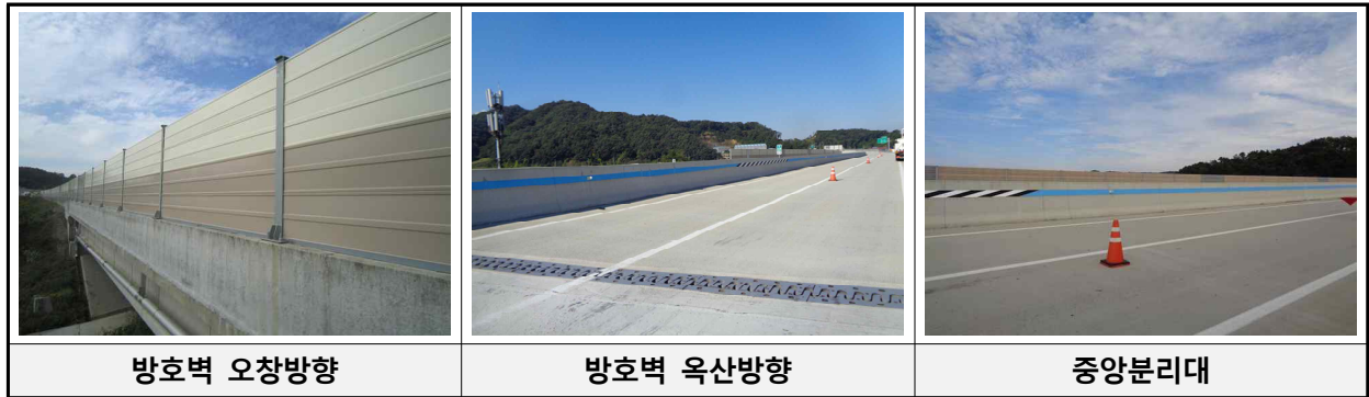
[방호벽 및 방음벽 전경]
