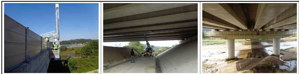
[고소작업차, 굴절점검차를 이용한 근접조사 실시]
